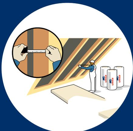
Změříme si šířku rozteče krokví. Pro zajištění lepší fixace minerální izolace URSA PUREONE DF 39 mezi krokveami přidáme k naměřenému rozměru ještě 2 cm.
