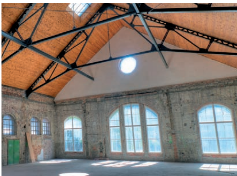
Vnitřní zateplení deskami Multipor v areálu Hlubina v Dolních Vítkovicích, Ostrava
