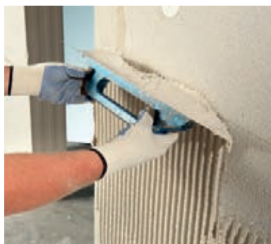
Nanášení první vrstvy Ytong lehčené omítky
