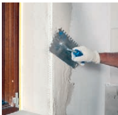
Instalace rohového profilu
