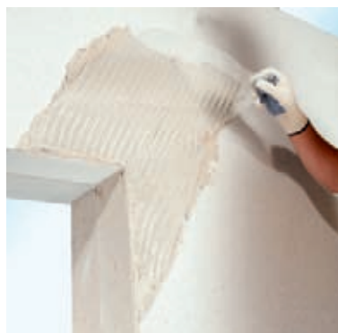
Provádění diagonální výztuže
