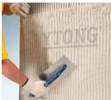
Vložení výztužné tkaniny Ytong
