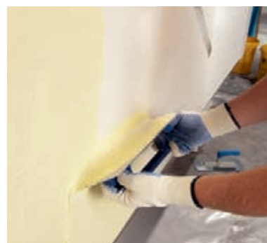
Nanášení finální vrstvy podle technologického předpisu výrobce
