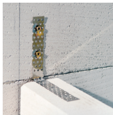
Dodatečné ukotvení k nosné konstrukci pomocí hřebíků s nerezovou úpravou.
