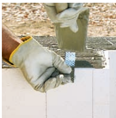
Spojka zdiva aplikovaná při stavbě nosné konstrukce.
