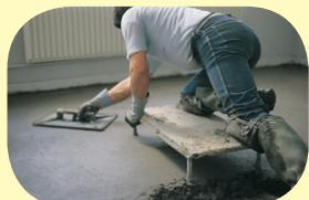
Povrch se zarovná do roviny stahovací latí nebo vibrační lištou s následným zahlašením povrchu hladítkem. Podle prostředí, ve kterém byla směs aplikována, se provádí její ošetřování (kropení vodou). Podlaha je pochůzná po 1 dni.
