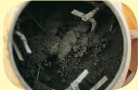
Do míchačky se nejdříve nadávkuje čistá voda ca 3,5 l na jeden pytel (25 kg) a za stálého míchání se vsypává suchá směs. Hmota se míchá ca 5 minut. Případně dodatečně přidání vody prováděme pomalu a opatrně tak, aby hmota na konci míchacího cyklu byla požadované konzistence.
