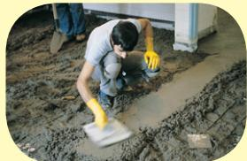
Hmota se nanáší na připravený podklad (případně do srovnávacích lišť). Hmota se aplikuje v tloušťce vrstvy od 10 mm do 100 mm.
