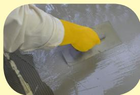
**Interiéry:** po rozmíchání můžeme první vrstvu nanášet hladítkem. Rohy aplikujeme štětkou. Necháme min. 6 hodin zavdchnout. Po této době aplikujeme druhou vrstvu opět hladítkem. Následuje technologická přestávka 12 hod, během které hmota dozrává. U silně namáhaných podlah doporučujeme aplikovat **terizol** zubovým hladítkem – viz aplikace v exteriéru.
