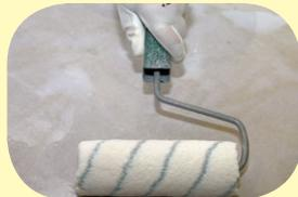
Nejprve provedeme penetraci podkladu. Savý podklad: **weberpodklad A** ředěný vodou v poměru 1:10. Nesavý podklad: **weberpodklad haft** a necháme cca 3 hod. zaschnout.
