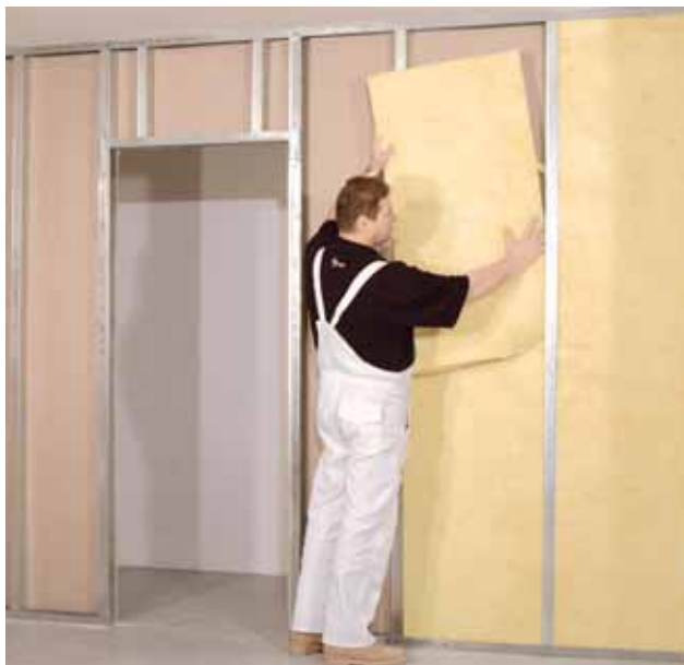
Vložení minerální izolace do dutiny příčky
