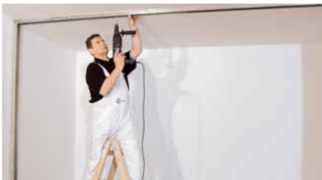
Montáž nosné konstrukce příčky – obvodové profily R-UW
