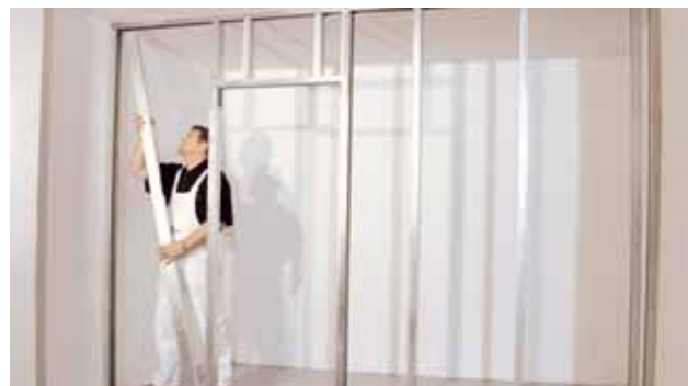
Montáž nosné konstrukce příčky – svislé profily R-CW
