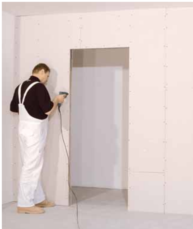
Montáž opláštění – druhá strana příčky
