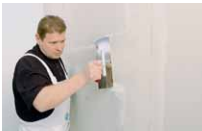
Roztážení a uhlazení tmelu
