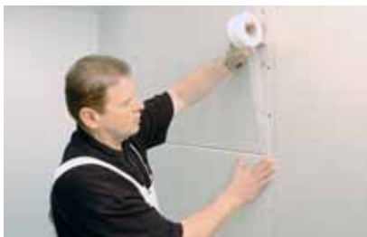
Nalepení samolepicí pásy
