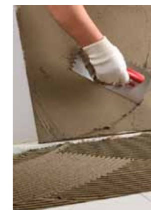
Obr. 13 – Lepení metodou buttering-floating
