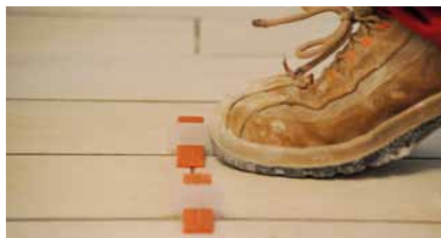
Obr. 9 – Odstranění klínků
