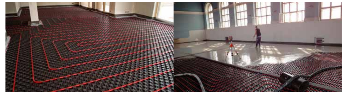
Obr. 16 – Příklad provedení podlahového vytápění – mokrý způsob
