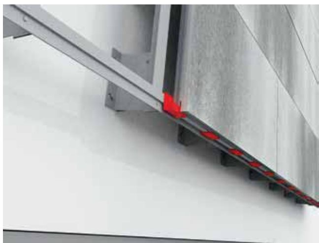
Obr. č. 7 Osazení obkladové desky do zakládacích kotevních prvků
