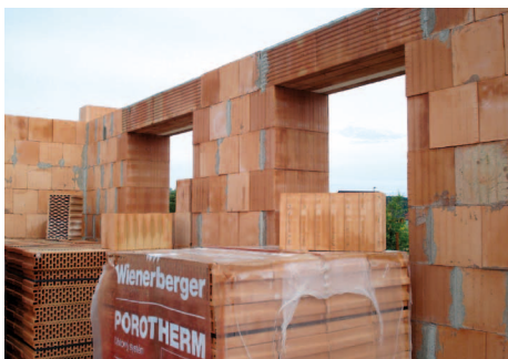
Uložení překladu na zdívo včetně vložení tepelné izolace
