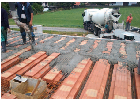
Betonáž stropu PTH BN
