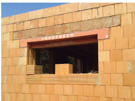
Stavba z T Profi s překladem Vario pro otvory nad 1,5 metrů
