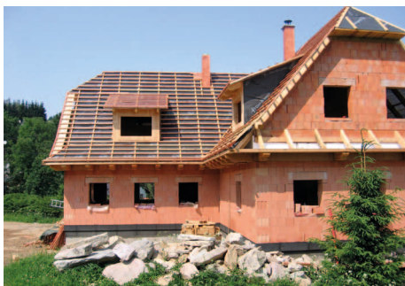
Dokončení laťování před klempířskými pracemi a pokládkou krytiny
