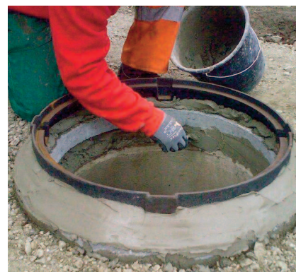
Šachtové rámy lze snadno a rychle osadit pomocí malty PCI Polyfix® plus.
