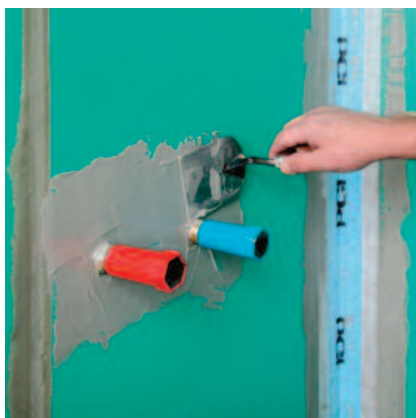
Také při utěsnění vodovodního potrubí těsnicí manžetou PCI Pecitape® 10 x10 je potřeba nejdříve nanést dostatečné množství hydroizolačního materiálu.
