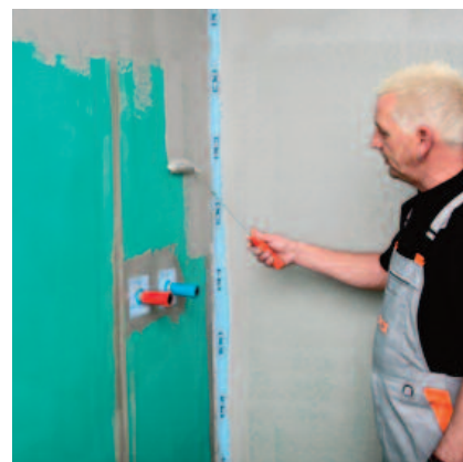
Po realizaci detailů následuje celoplošná hydroizolace.
