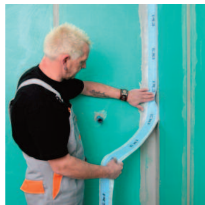
Následně umístit těsnicí pásku PCI Pecitape® 120 nebo PCI Pecitape® Objekt a zlehka přitlačit ...
