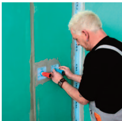
... těsnicí manžetu opatrně natáhnout přes stavební zátku na distanční prvek a usadit do čerstvé hydroizolace.
