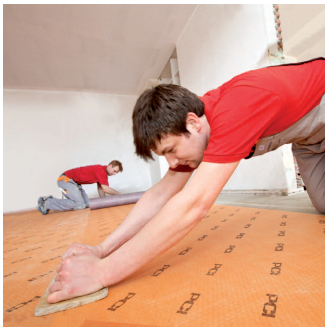
2. PCI Pecilastic® U se při pokládce řádně přitlačí k podkladu pomocí dřevěného prkna, nebo desky z tvrdé gumy.
