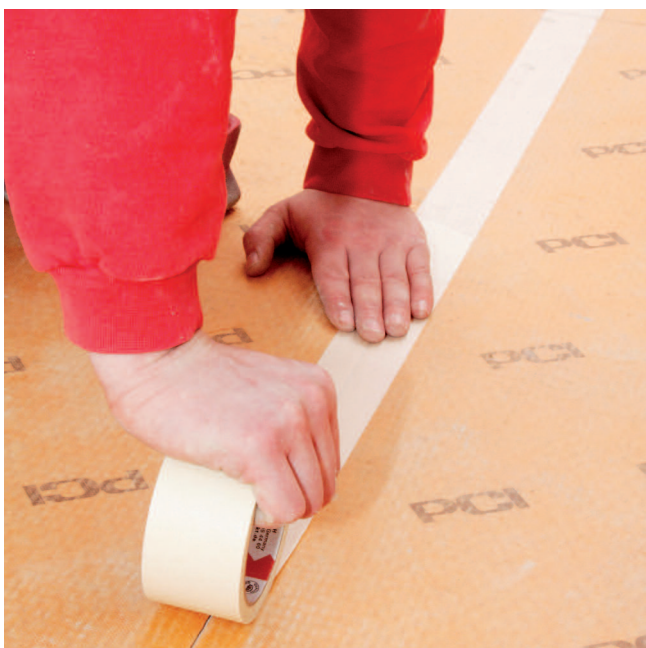
3. V suchých prostorech se jednotlivé spoje slepí lepicí páskou, v prostorech zatížených vlhkostí se izolují pomocí PCI Pecitape® 120, PCI Pecitape® Objekt nebo PCI Pecitape® Butyl...
