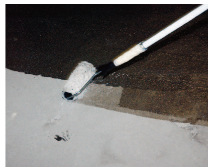
PCI Epoxigrund Rapid se aplikuje na připravený povrch například štětkou nebo válečkem.
