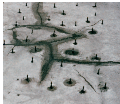
Vyplnění trhlin a injektáže dutin potěru hmotou PCI Apogel® F.
