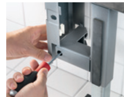
↑ Nosný rám má dva stavitelné šrouby pro kompenzaci nakloněné stěny.
