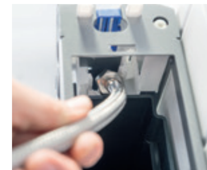
↑ Opletená připojovací hadička pro přívod vody může být nainstalována bez nutnosti odstranění splachovací nádržky, což ušetří jeden pracovní úkon.
