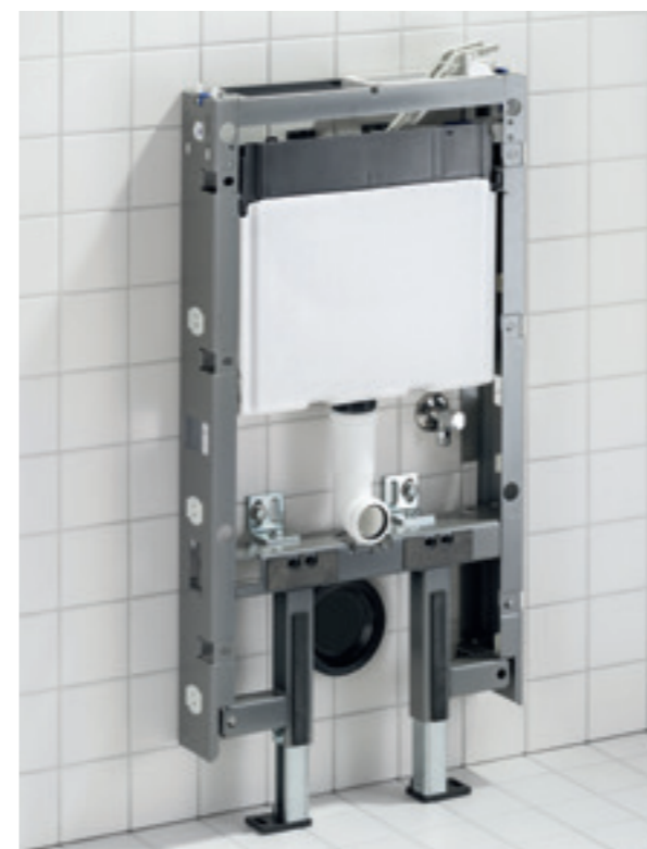
↑ Nainstalovaný nosný rám pro nový sanitární modul Geberit Monolith pro WC. Rám je ukotven do stavební konstrukce ve čtyřech bodech a splachovací nádržka je připojena ke stávající vodovodní přípojce.
