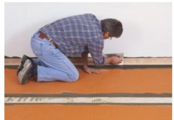
5. Aby se předešlo poškození pásu nebo jeho odlepení od podkladu, je nutno Schlüter®-DITRA 25 po položení chránit (především v místech, používaných pro přepravu materiálu) před mechanickým zatížením položením prken apod. Právě tak mohou být nutná ochranná opatření v exteriéru v případě přímého slunečního svitu nebo při dešti. Případná voda nashromázděná ve výliscích rohože musí být odstraněna před nanesením tenké vrstvy malty/lepidla.
