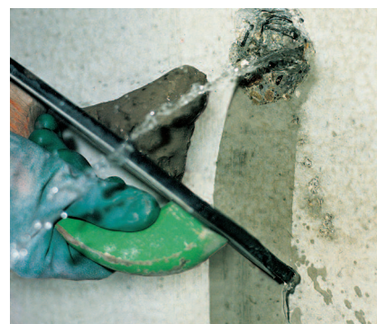
Bleskovou montážní maltou PCI Polyfix® 30 Sek. je možné rychle utěsnit průsaký vody.
