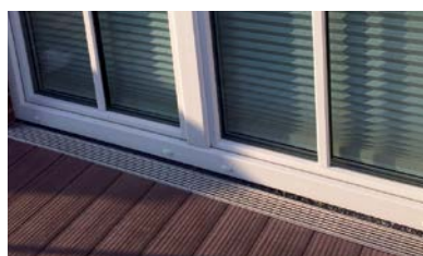
Terasa s ACO Self® Highline: drenážní žlab bez přípojky
